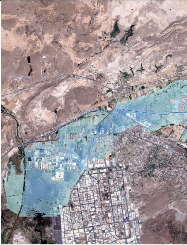
Şekil 55- Kayseri Kocasinan Kuşaklama Kanalı
