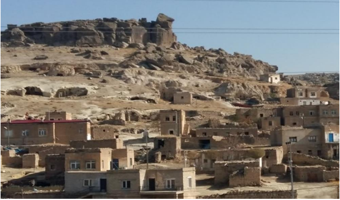
Şekil 21- İlimizden Kaya Düşmesi Olayı (Yeşilhisar-Doğanlı Mahallesi)
